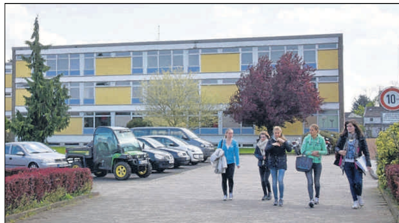
So sahen die verwaisten Internatsgebäude am Vinzenz-Pallotti-Kolleg in Rheinbach aus, bevor die Bagger an der Pallottistraße anrückten.
