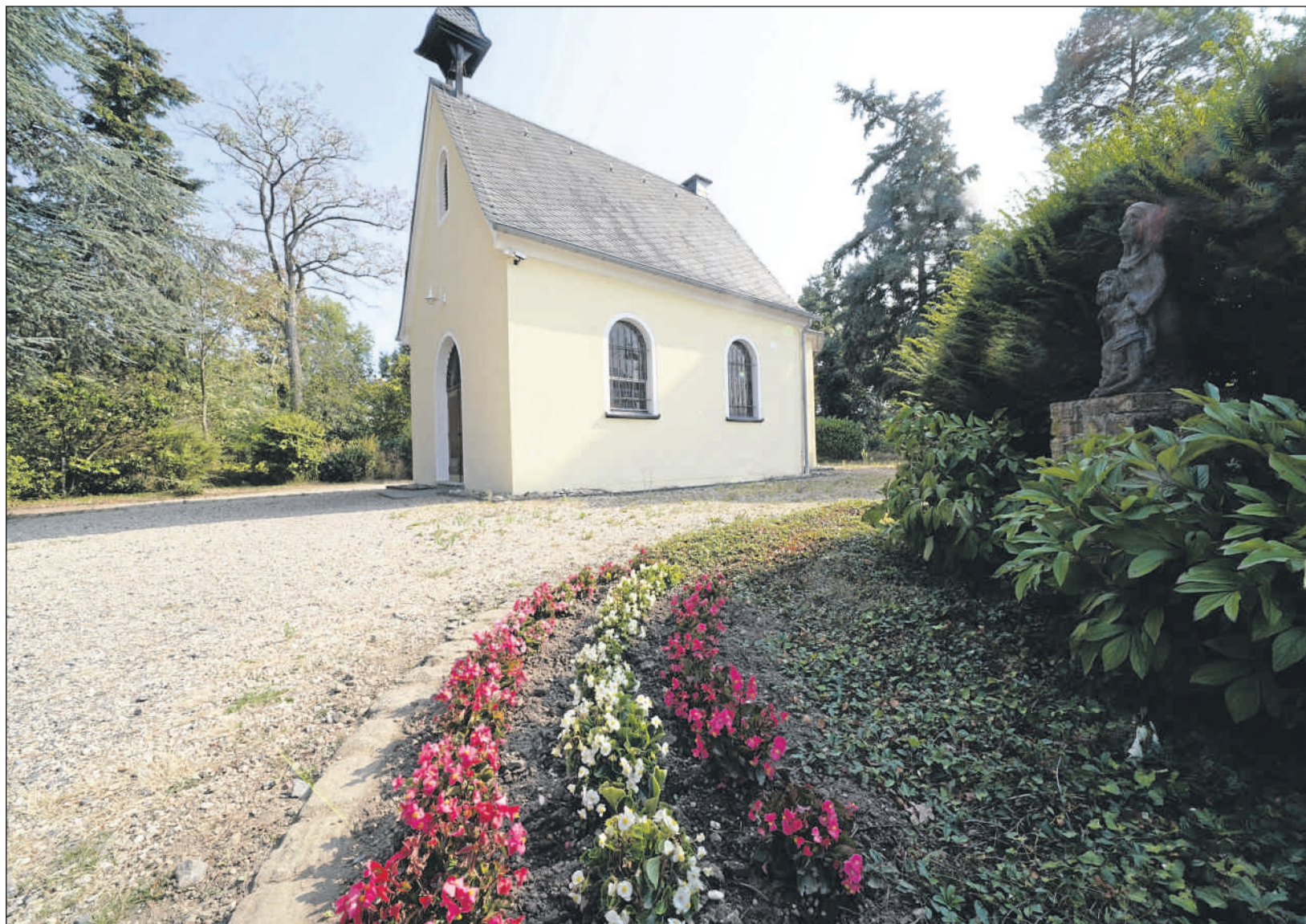
Dank Bürgerengagements in gepflegtem Zustand: Die Marienkapelle wurde 2006 renoviert.
